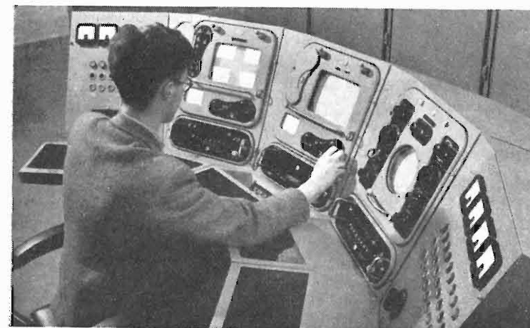
Il banco di controllo dei ripetitori a media potenza (5 kW, video, e 2 kW, audio) della nuova stazione trasmittente TV di Holme Moss nello Yorkshire. Come abbiamo reso noto in un nostro servizio particolare («L'antenna», XXIII, n. 11, novembre 1951, pag. 246) il trasmettitore di Holme Moss è entrato in funzione il 12 ottobre scorso.
